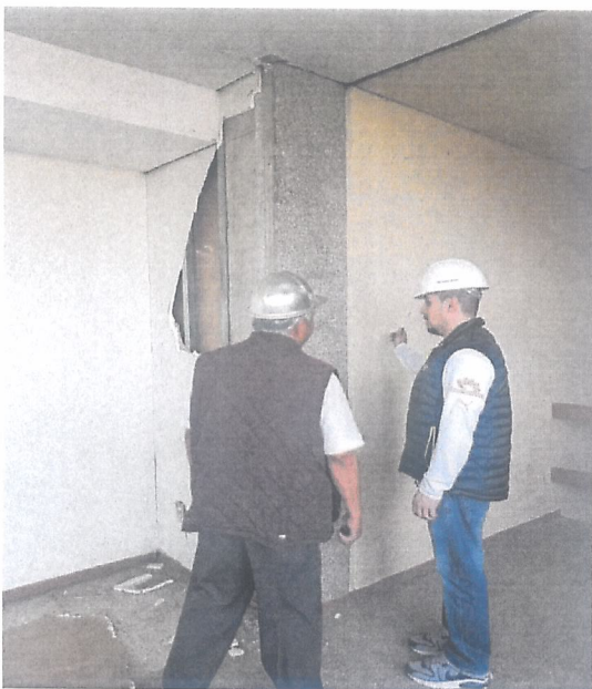
En diferentes áreas se presenta desprendimiento de muro de tablaroca en columnas de la unidad
