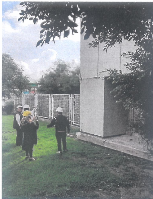
En entre eje del área de farmacia se aprecia un ligero asentamiento diferencial con el edificio, se observa desprendimiento de recubrimiento en columnas
