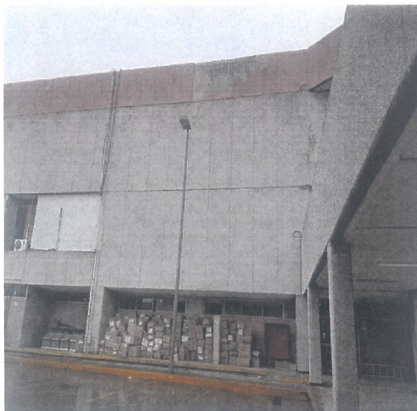
Se observa fachada posterior de la Unidad, solo se desprende recubrimiento en pretil
