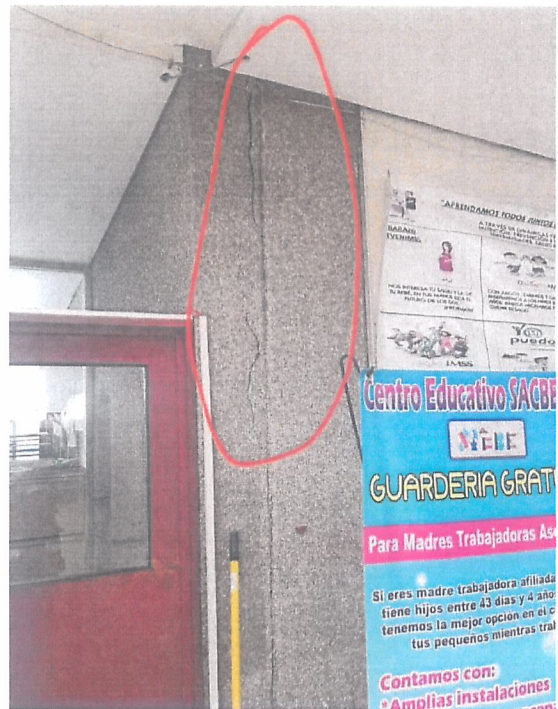
En área de servicios general planta baja, se observa cajillo desprendido de la columna, sin daño estructural
