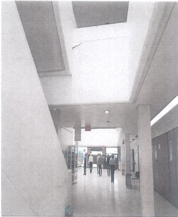
En pasillo junta a escaleras, se observa desprendimiento de recubrimiento de pasta en pretil
