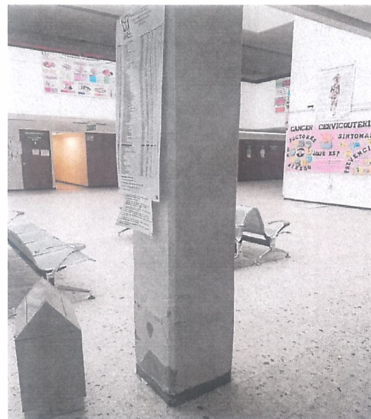
En columnas del atrio, solo se observa desprendimiento de pasta en columnas, sin daño estructural
