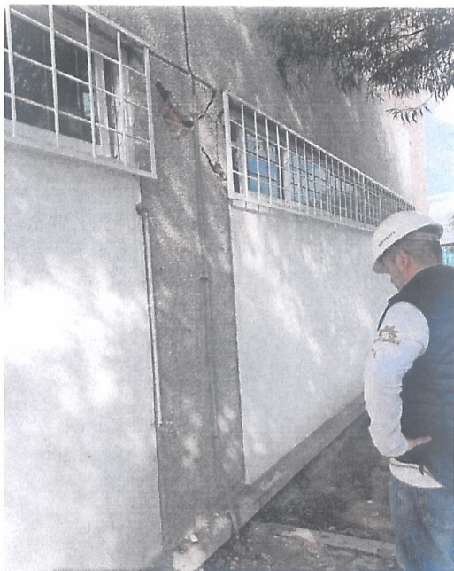
Se observa desprendimiento de recubrimiento de tabique rojo en columnas
