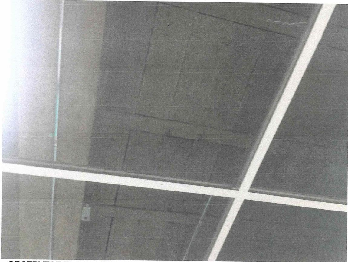
**OBSERVESE EL SISTEMA DE PISO A BASE DE VIGUETA-BOVEDILLA APOYADO
