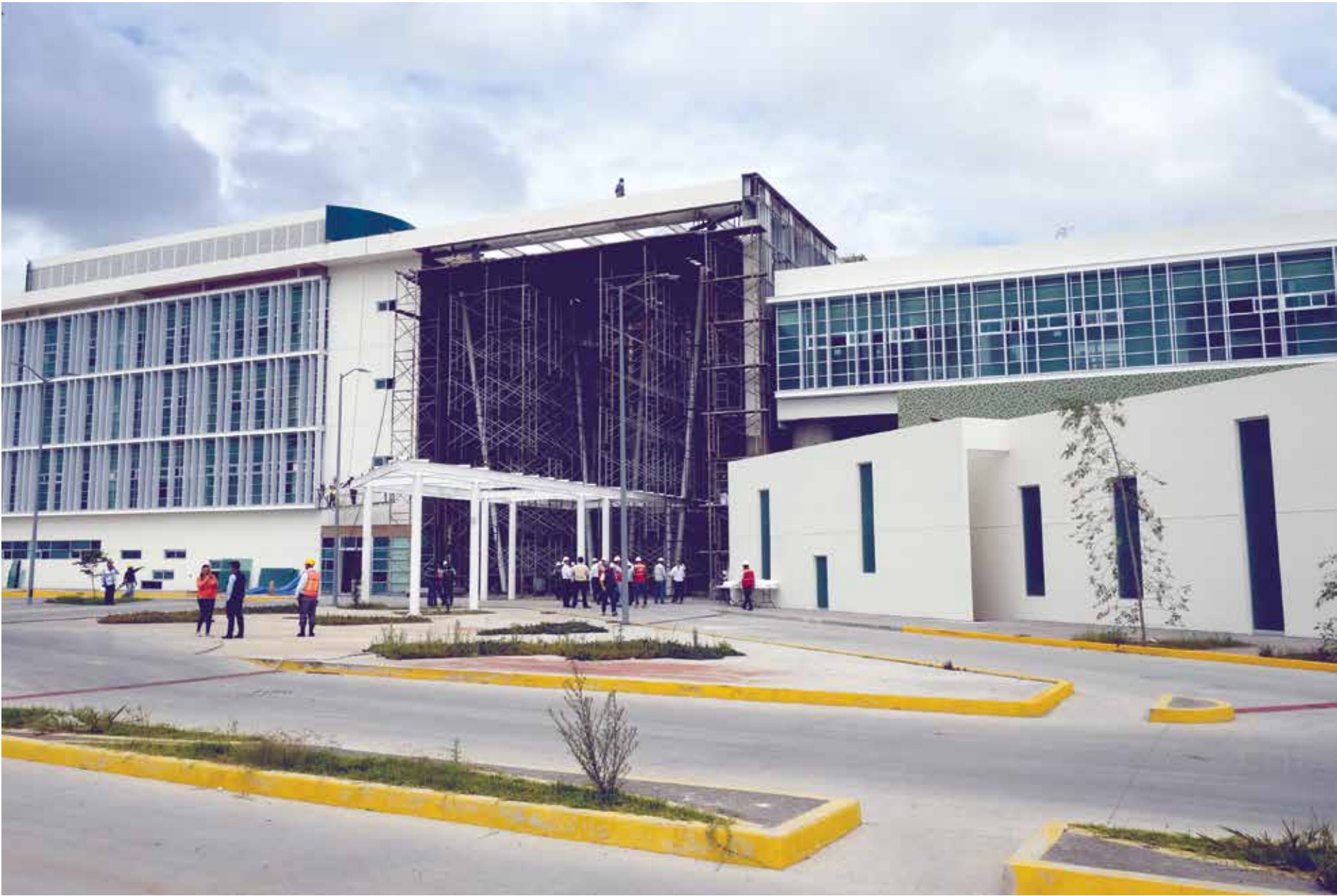
Realización de peritajes para contar con instalaciones seguras.
